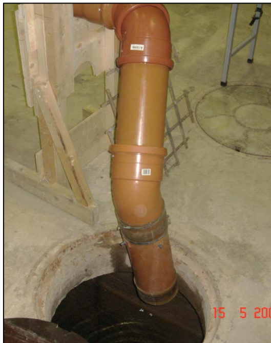
Figur 38 Utløp avløpstunnel (Røneid & Sæter, 2007)
