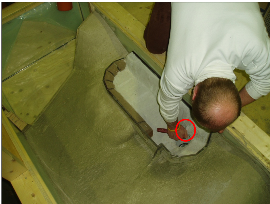
Figur 9 Bygging av samlekanal terreng (Røneid & Sæter, 2007) Rød sirkel: kul over sjaktinnløp
